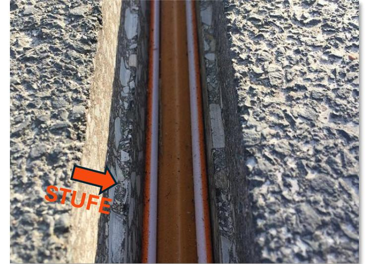
Fertiger **Stufenschlitz** mit Stufe, Rohrverbünde im Verlegeraum (unten) und Verfüllraum (oben)
