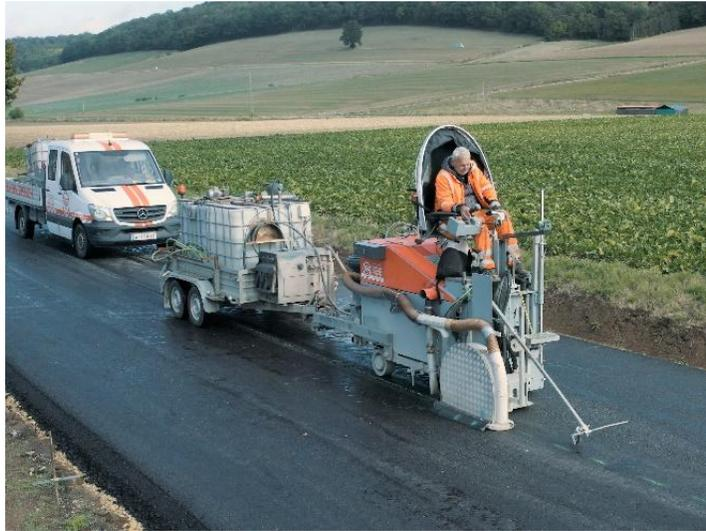
**Schleifmaschine** im Nass-Schleifverfahren. Mit Absaugung und Beschickung.
