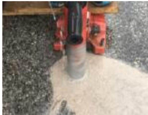
Durch Probe-Bohrungen (Bohrkern 40-50mm) werden Aufbau und Qualität des Asphalts im Vorfeld analysiert.
